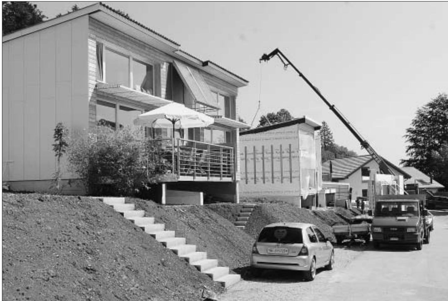
Outre une vue magnifique, le site offre une position optimale pour l'application des énergies renouvelables dont bénéficient les huit petites maisonnettes.
