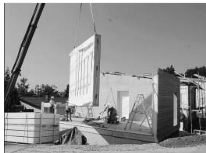
A part deux petits murets en béton, chaque maisonnette est entièrement construite en bois.
