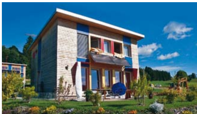
QUARTIER DES MONTS AU LOCLE. En cours de réalisation suivant le modèle novateur du lauréat: Pro-cité.
