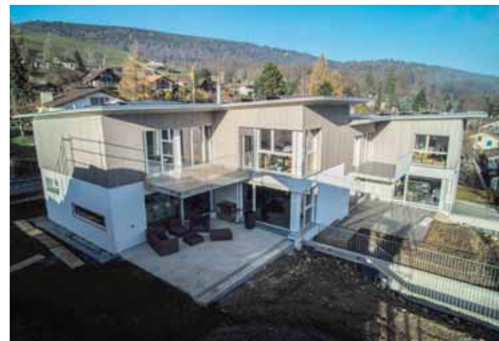
De grandes baies vitrées au sud permettent d'utiliser l'énergie thermique.
